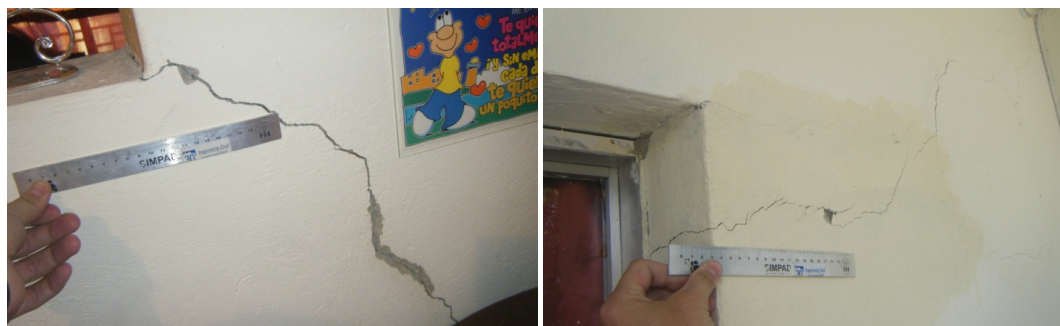
c) Grietas presentadas en el segundo piso de la edificación
