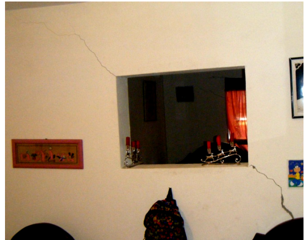
Figura 11: Ejemplo Grieta NDTC
