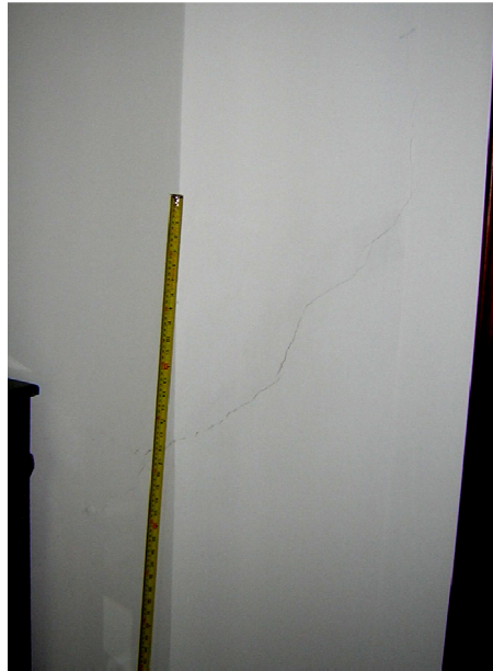
Figura 58: Discontinuidad 10 - NDTC caso 2
