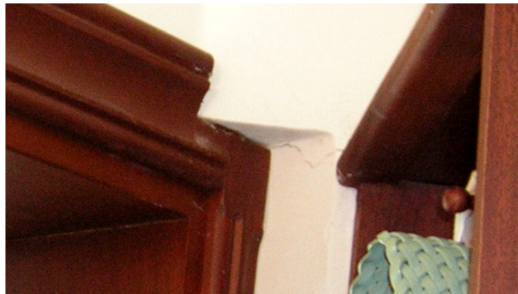
Figura 57: Discontinuidad – NHTC caso 2
