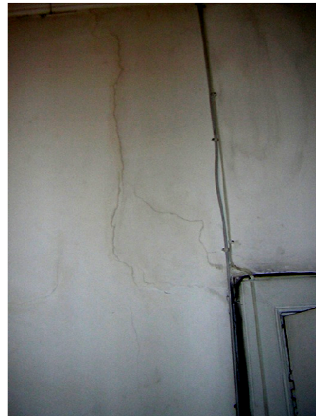
Figura 16: Ejemplo Grieta NDCC
