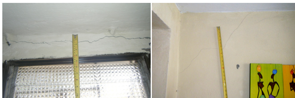
b) Grietas presentadas en el primer piso de la edificación
