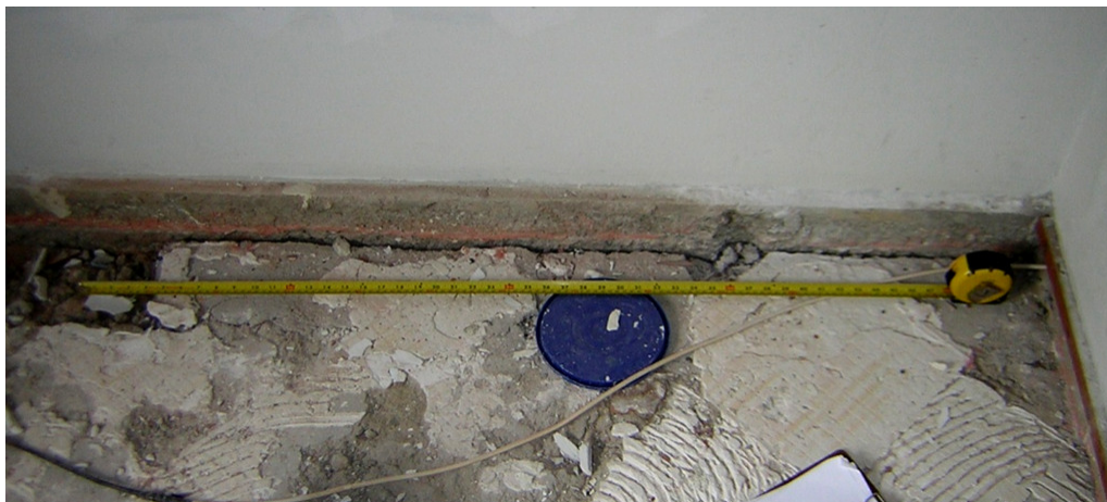
Figura 51: Discontinuidad 1-PPTC losa caso 1
