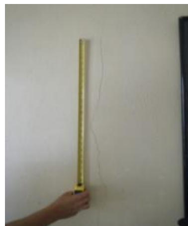
Figura 2: Ejemplo de fisuras
