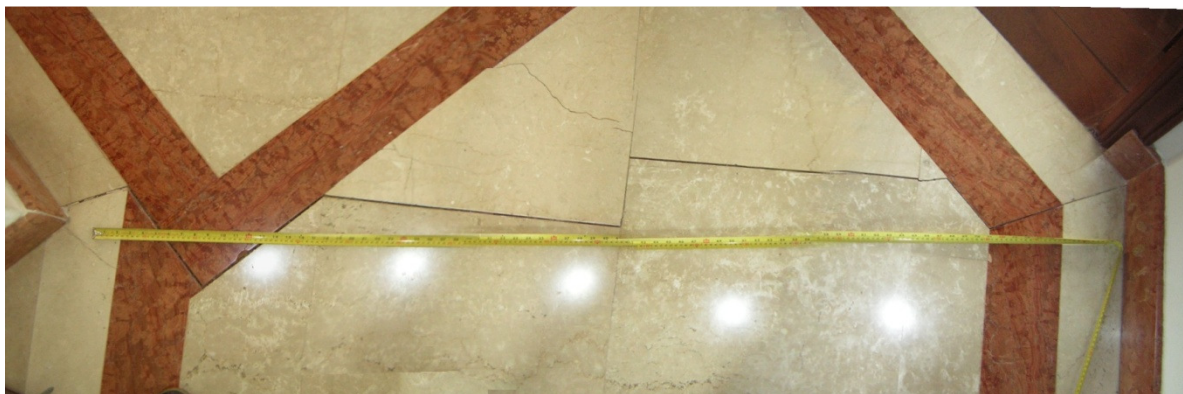
Figura 29: Ejemplo de grieta PPTC
