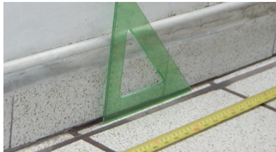
Figura 38: Desprendimiento de zócalo debido al levantamiento del muro
