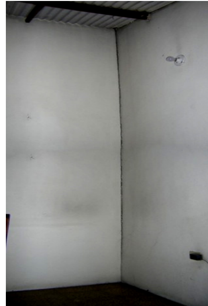
Figura 13: Ejemplo Grieta NVSC
