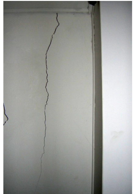
Figura 9: Ejemplo Grieta NVTC-1
