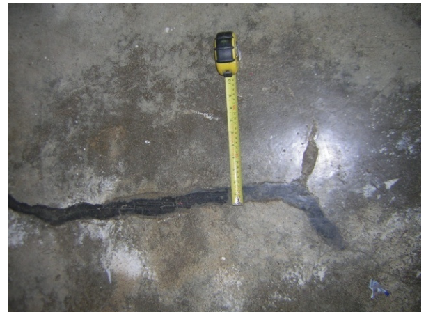
Figura 19: Ejemplo Grieta NPTC
