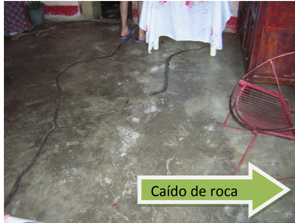
Figura 28: Grietas presentadas en losas por el jalón causado por los caídos de roca
