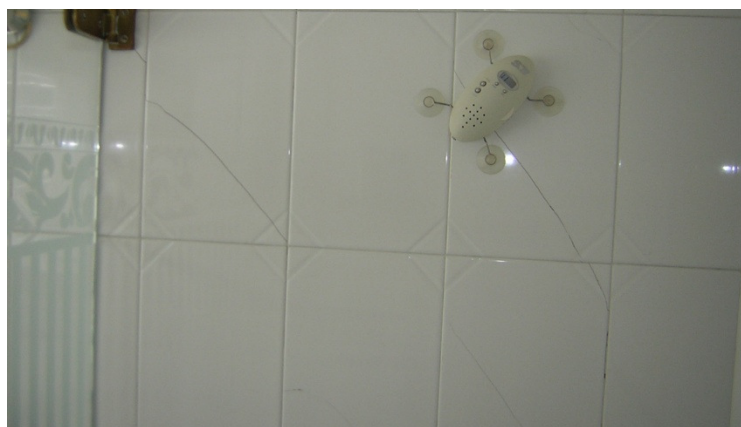
Figura 66: Discontinuidad 18 – NDTC caso 2
