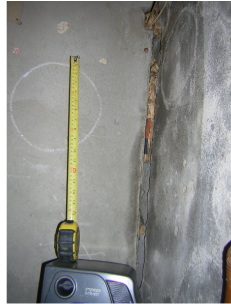
Figura 23: Ejemplo Grieta RVSC
