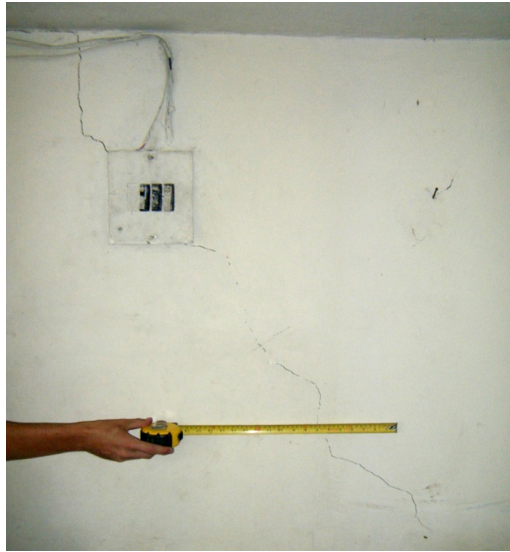
Figura 32: Ejemplo de fisura geotécnica (NVTC-2) con influencia de instalaciones eléctricas
