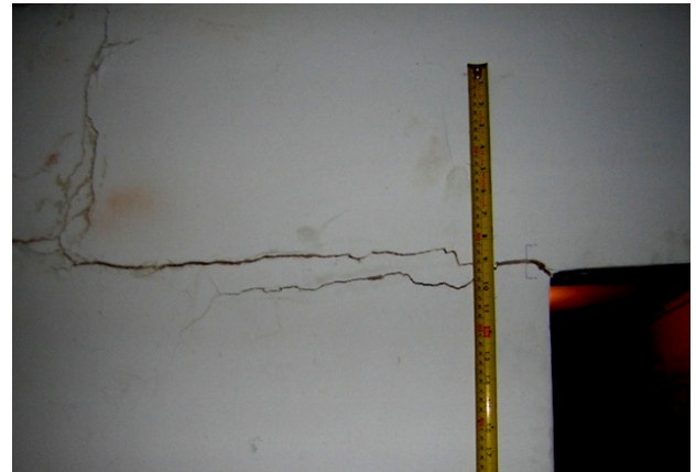
Figura 12: Ejemplo Grieta NHTC
