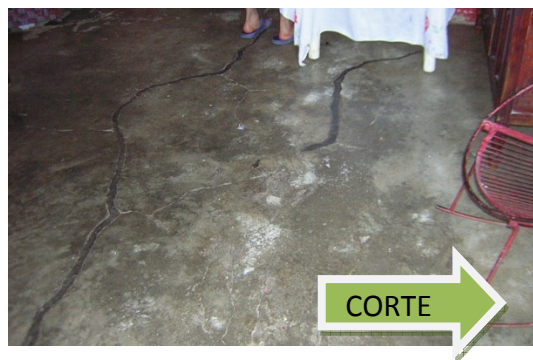
c) Grietas en losa debido al corte
