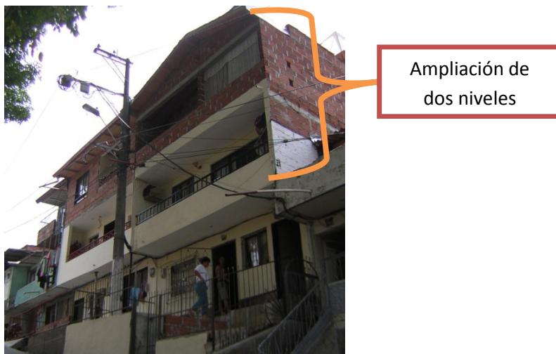
a) Ampliación de la casa en dos niveles
