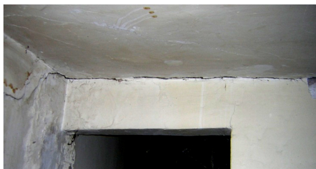
Figura 6: Ejemplo de grietas a cortante
