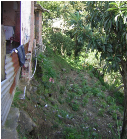
a) Corte aledaño a casa
