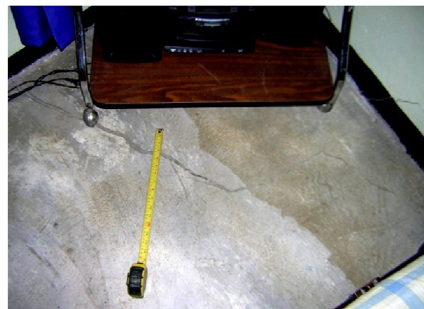
Figura 18: Ejemplo Grieta NOTC
