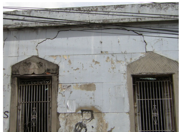
Figura 15: Ejemplo Grieta NVCC
