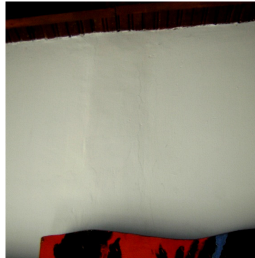
Figura 21: Ejemplo de la grieta RVTC-2
