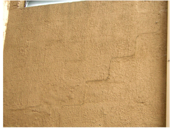
Figura 5: Ejemplo de aparición de grietas en zonas de morteros de pega pobres
