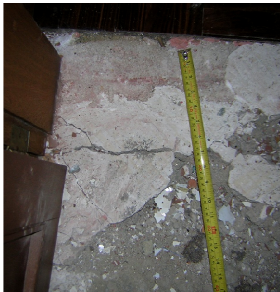
Figura 50: Discontinuidad 13-NPTC losa caso 1
