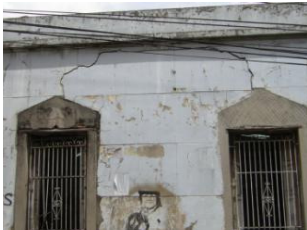
Figura 1: Ejemplo de grietas
