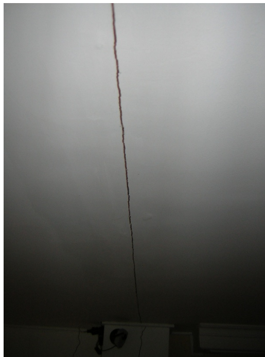
Figura 48: Discontinuidad 11-PPTG caso 1
