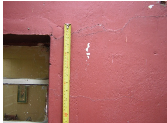
Figura 17: Ejemplo Grieta NHCC
