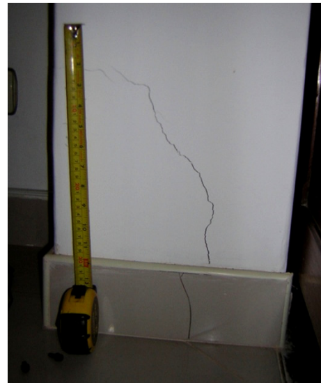
Figura 10: Ejemplo Grieta NVTC-2
