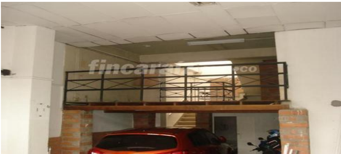
Figura 15 Zona para adecuación.
