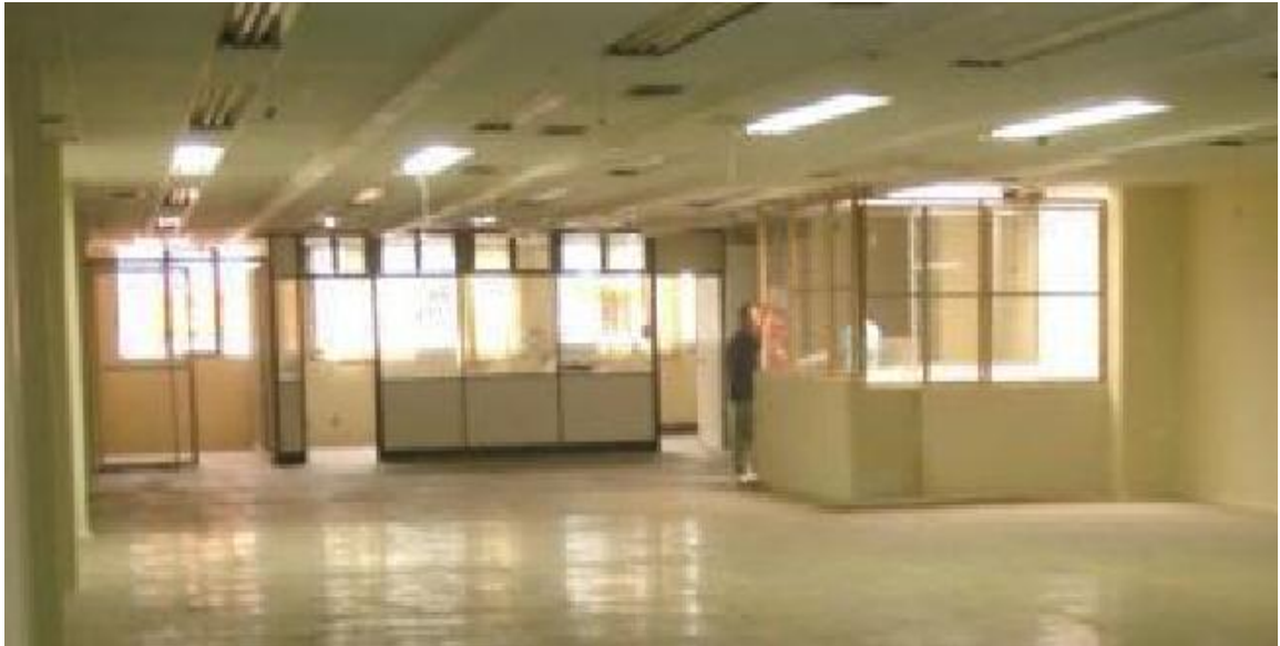
Figura 12 Zona de Oficinas
