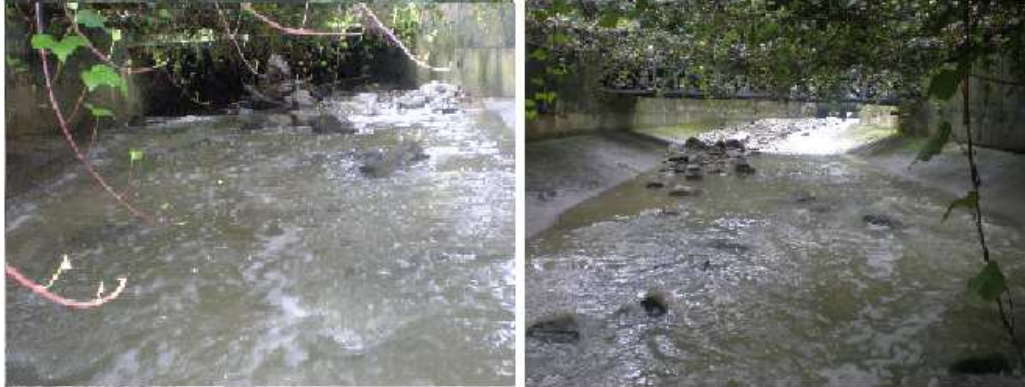
Figura 15. Box culvert dentro de la universidad EAFIT, b) Agua arriba del Box culvert dentro de la universidad EAFIT.
