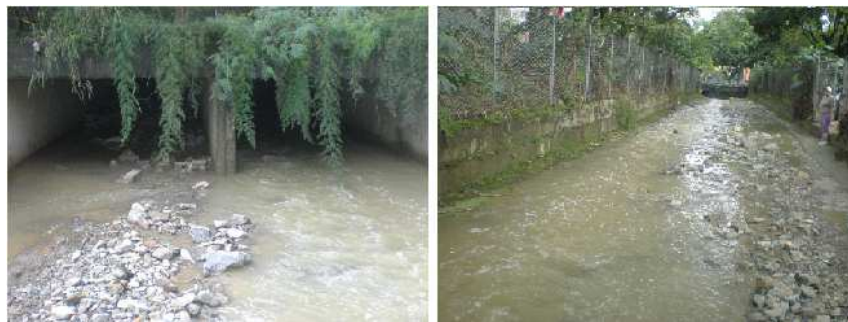
Figura 14. a) Box culvert de la avenida las Vegas, b) agua abajo del box culvert, avenida las Vegas.
