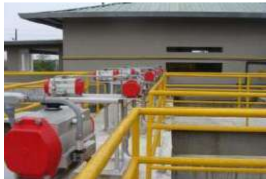
Imagen 2. Aspecto actual de la planta de potabilización.
