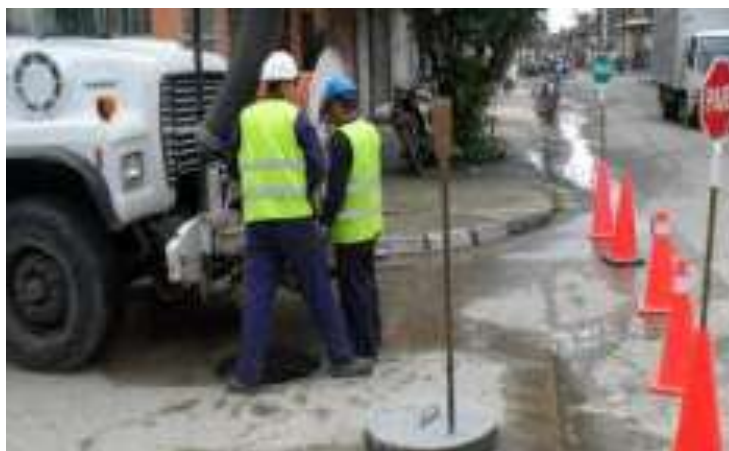
Imagen 5. Actividades de desobstrucción de redes de alcantarillado con vehículo Vactor.
