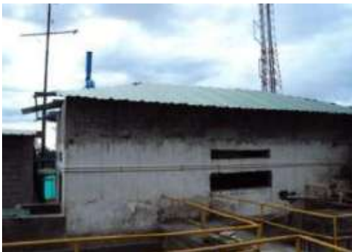
Imagen 1. Antiguas instalaciones de la planta de potabilización.
