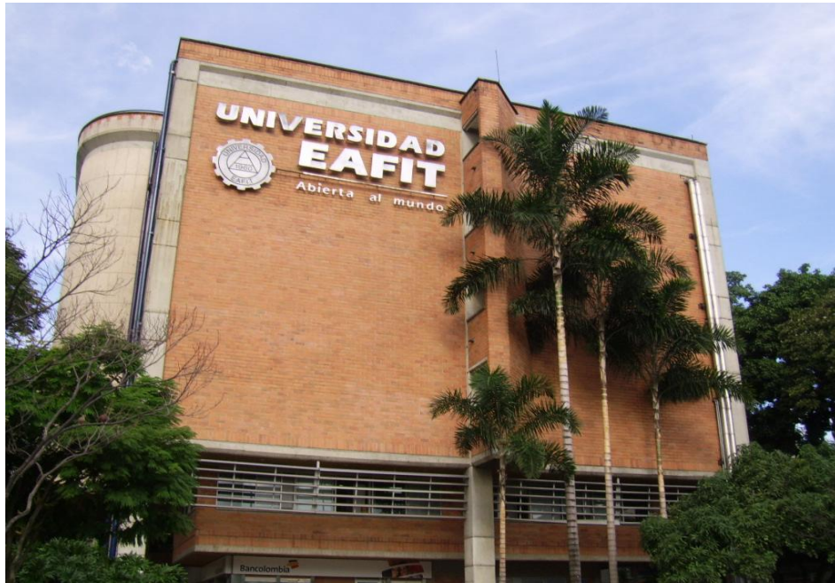
Figura 6.4. Vista lateral (costado occidental) del bloque 18
