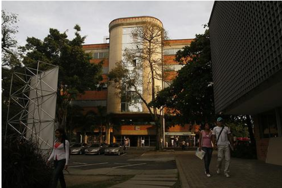
Figura 6.2. Vista frontal (costado norte) del bloque 18
