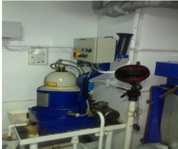
Ilustración 28 Purificadora de diesel
