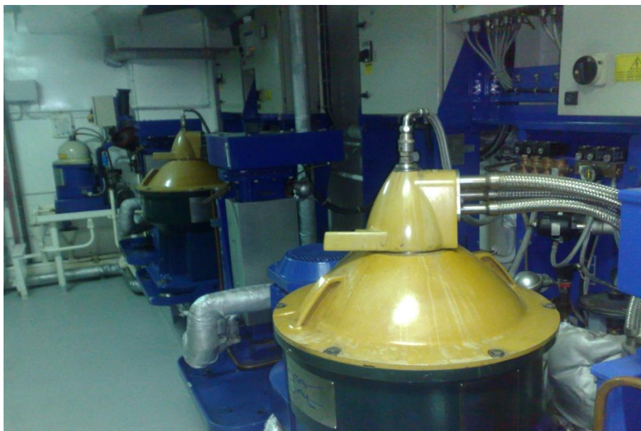
Ilustración 27 Purificadora fuel oil
