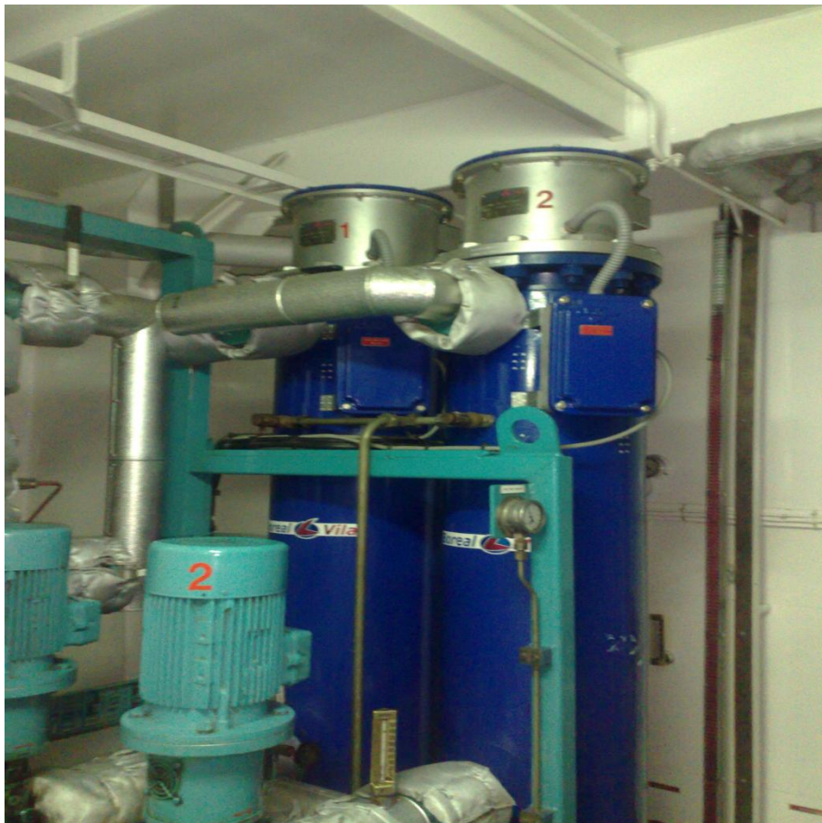
Ilustración 32 Bomba de circulación de combustible
