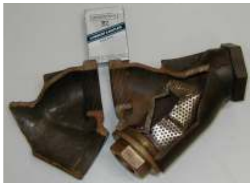
Ilustración 57. Filtro malo debido al golpe de ariete.
