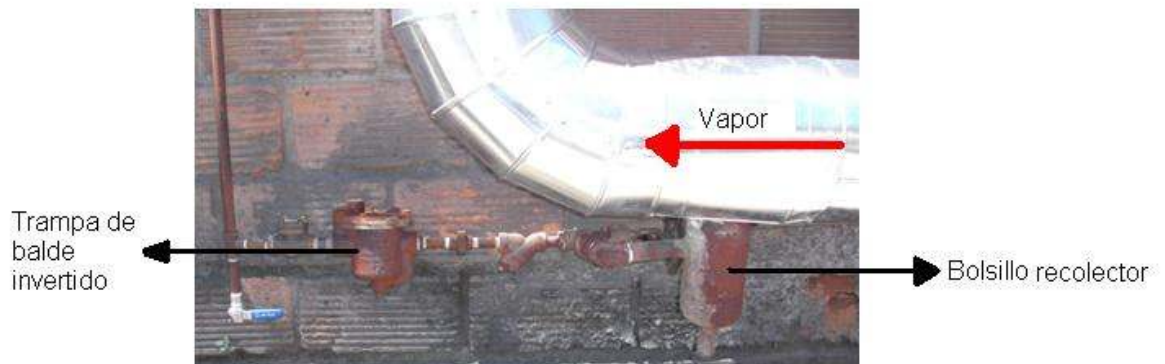
Ilustración 29. Trampa de balde invertido ubicada en la línea principal de vapor con bolsillo recolector.
