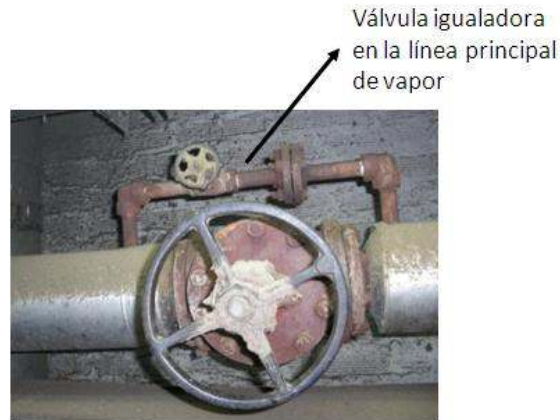
Ilustración 37. Válvula igualadora de presión de vapor.
