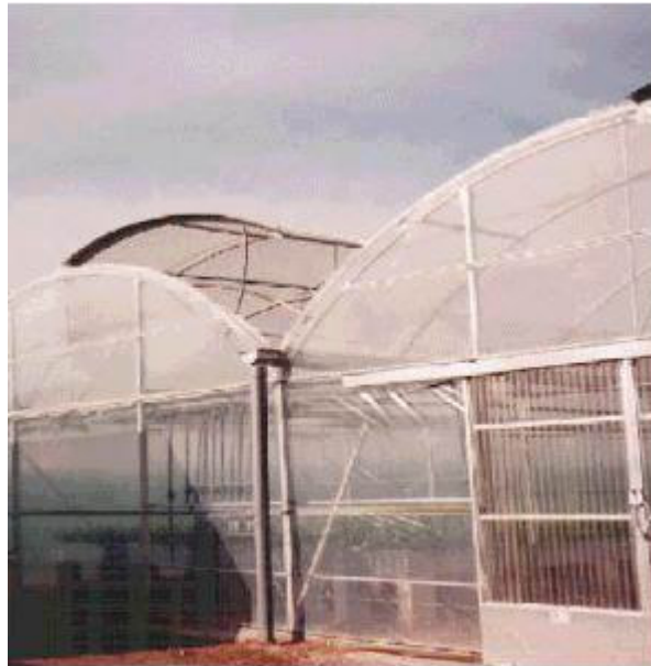
Figura 6. Imagen invernadero exterior
