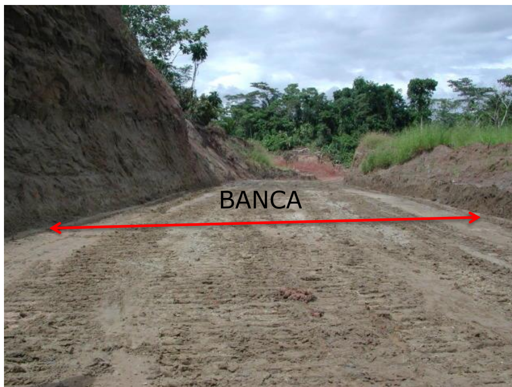
Figura 3.13. Banca en excavación
