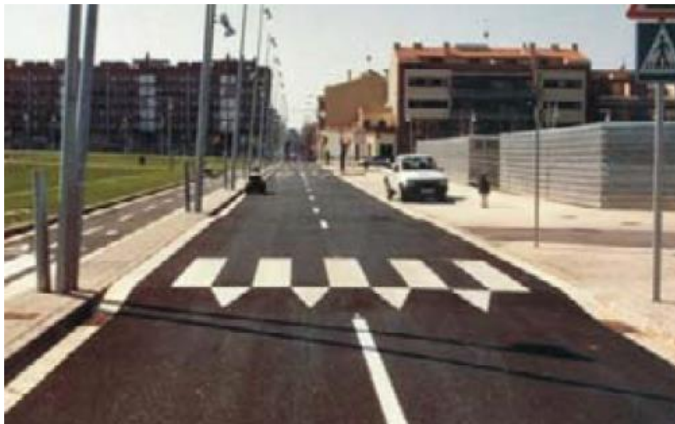
Figura 10.8. Paso elevado de peatones a través de pompeyanos (1).
