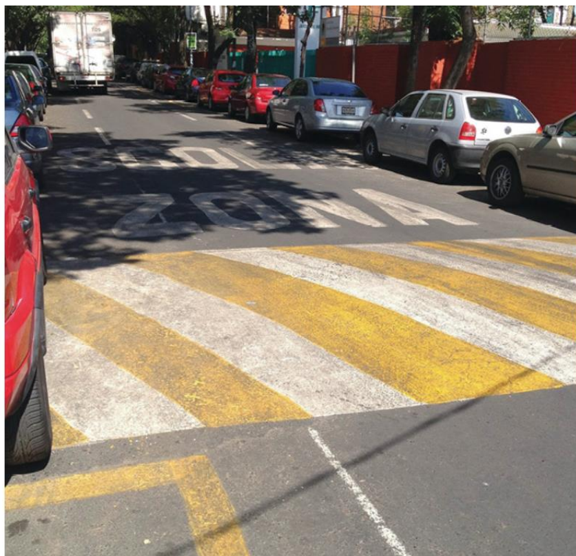
Figura 10.10. Reductores de velocidad.
