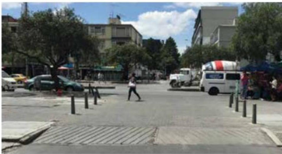
Figura 10.9. Paso elevado de peatones a través de pompeyanos (2).
