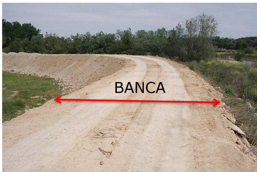
Figura 3.14. Banca en terraplén
