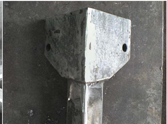
Fotografía 30. Soldadura pulida
