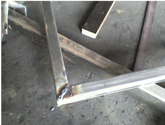
Fotografía 29. Soldadura tubería y láminas
