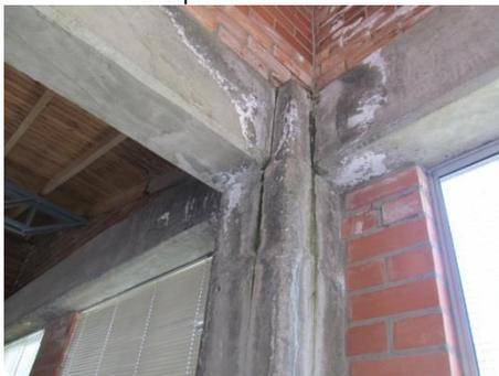
Filtraciones de agua – elementos estructurales afectados
