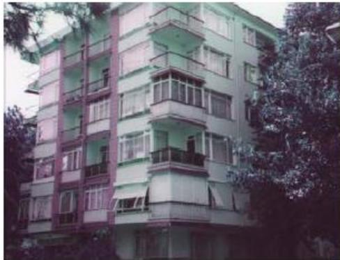
**Figura 6.6 Edificio típico – pórticos con muros de mampostería simple (Gulkan *et al.*, 2002)**
