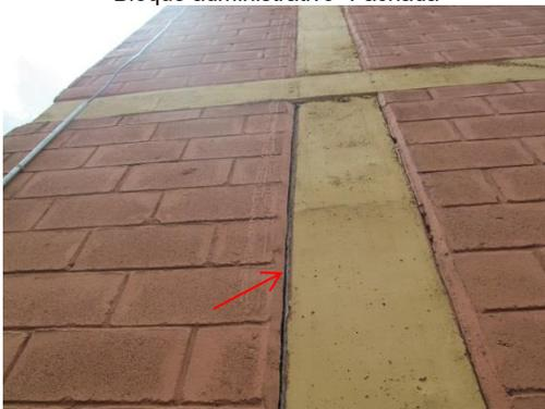
Desprendimiento del muro de la estructura - asentamiento
