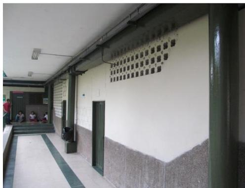
Muros separados de la estructura
