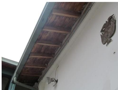
Falta de mantenimiento de la estructura de cubierta
