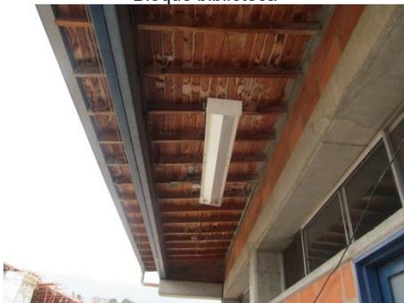
Cubierta afectada por filtraciones de agua
