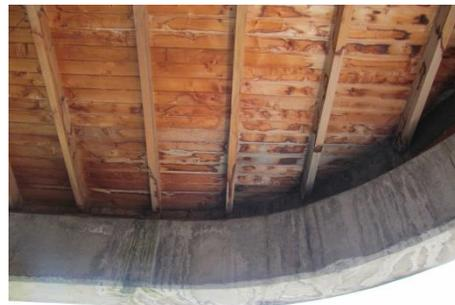
Cubierta en mal estado – eflorescencias en el concreto
