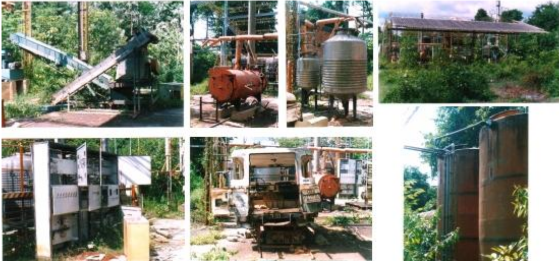
Ilustración 12. Estado actual de la Planta de alcoholes de Urabá
