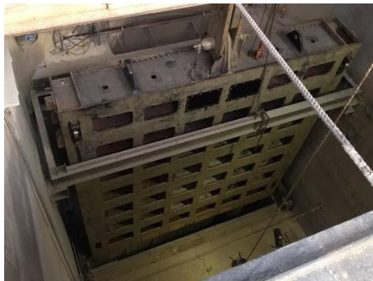
Foto 2. Compuerta con asas de izaje.
