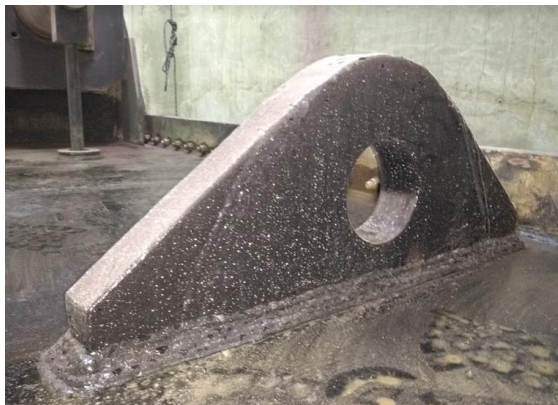
Foto 3. Asa de izaje para des-atascamiento.
