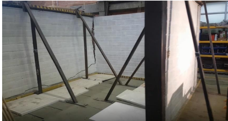
Figura 6.11 Momento exacto de la falla del muro del ensayo 4-T2-7-408-0-S (vista diagonal)
