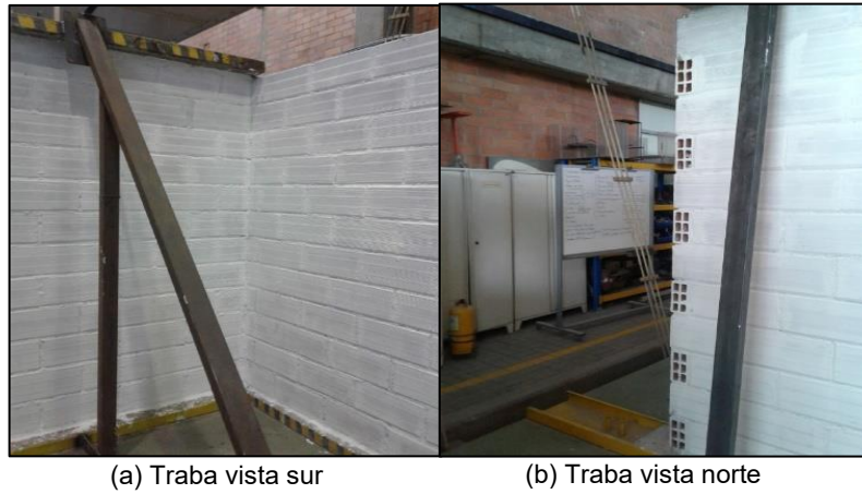
Figura 6.5 Estado del muro luego del ensayo número 2-T3-7-408-V-S
