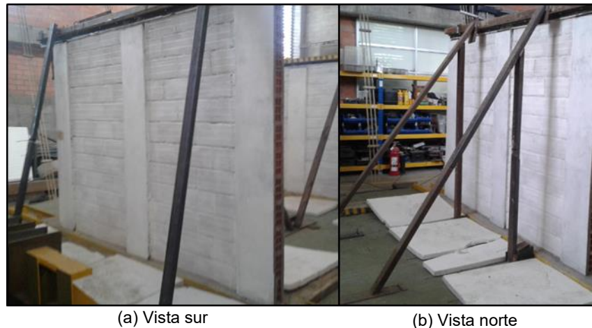
Figura 6.22 Apariencia del muro del ensayo 8-T1-1-325-0-R
