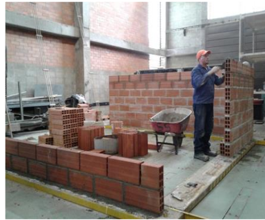
Figura 5.11 Construcción de los ensayos 6-T1-1-325-0-S (frente) y 7-T2-1-408-0-S (fondo)
