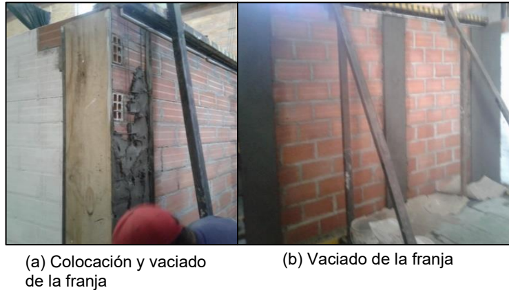
Figura 5.13 Construcción de las franjas en el ensayo 9-T2-1-408-0-R
