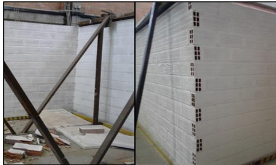
(a) Traba vista norte (b) Traba vista sur
