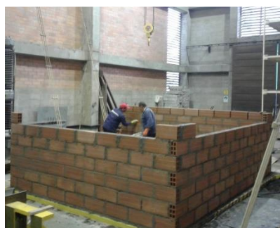
Figura 5.8 Construcción de los ensayos 1-T3-7-328-V-S (frente) y 2-T3-7-408-V-S (fondo)
