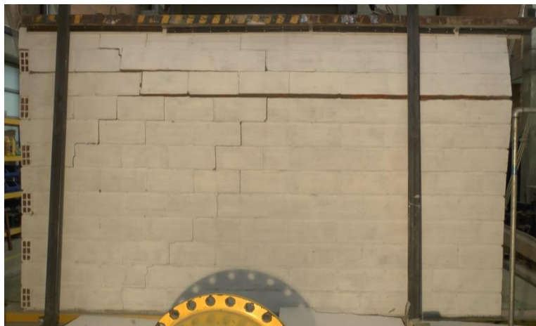
Figura 6.20 Momento de la falla del muro del ensayo 7-T2-1-408-0-S (vista norte)
