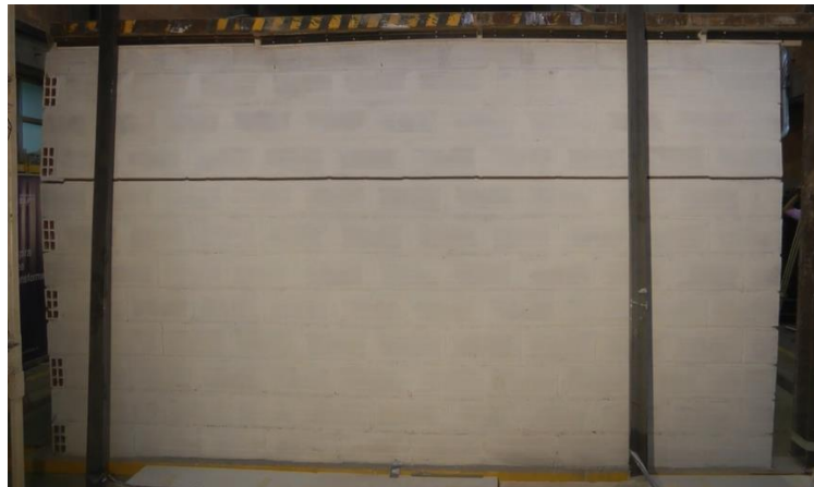
Figura 6.12 Momento exacto de la falla del muro del ensayo 4-T2-7-408-0-S (vista norte)
