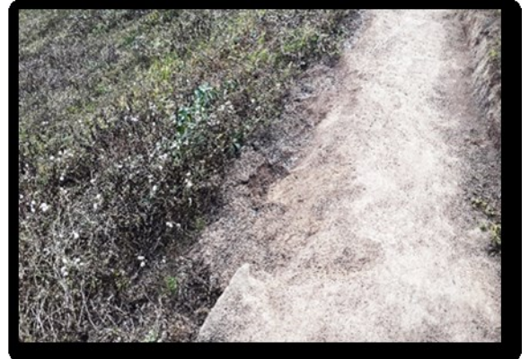
Camino con desprendimiento
