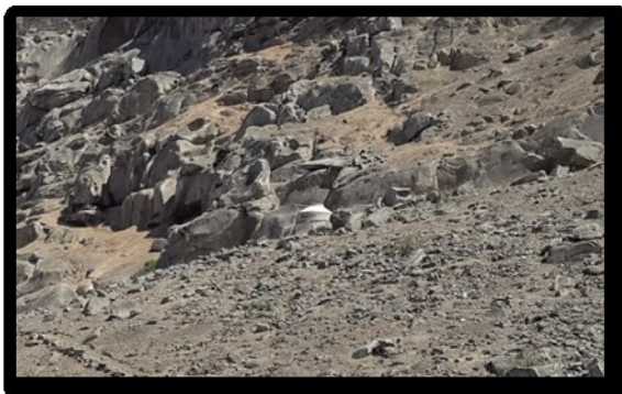
Tanque de agua del sistema de riego.
