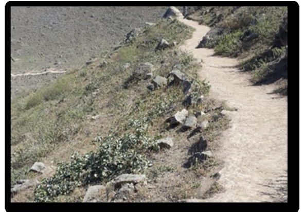
Deslizamiento del borde de piedras
