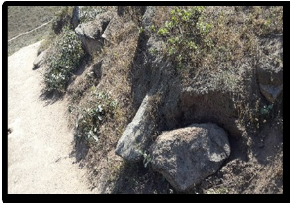
Derrumbe de piedras
