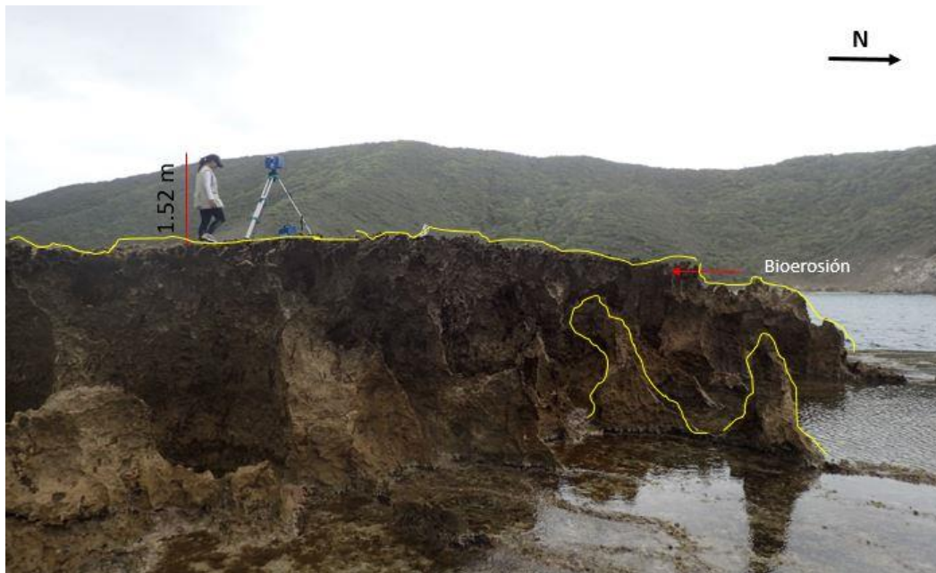
Figura 19. Bioerosión en el eje vertical de las terrazas.
