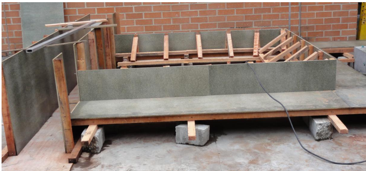
Figura 5.13. Formaleta parcialmente ensamblada
