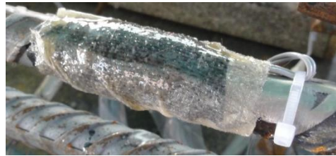
e) Protección mecánica con resina de poliéster
