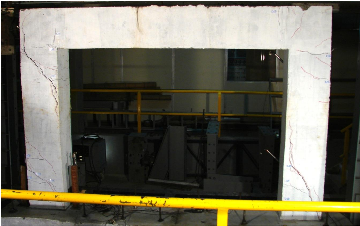
Figura 7.3. Estado final del pórtico P2
