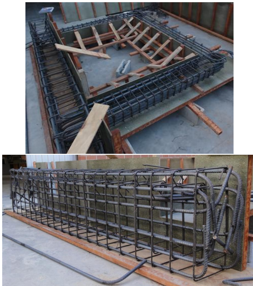
Figura 5.14. Ensamble del refuerzo. Arriba: todos los elementos. Abajo: viga de fundación
