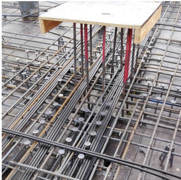
Figura 18: Studrails colocados en la conexión losa-columna
