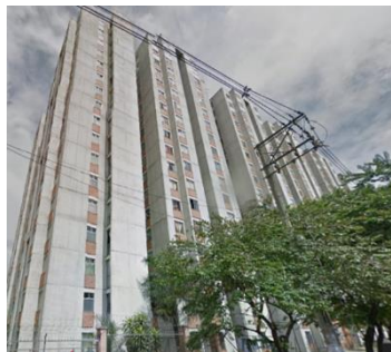
Figura 3. Edificación en muros de concreto reforzado presente en la ciudad de Medellín, © Google 2016.
