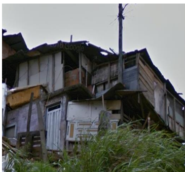
Figura 8. Grupo de estructuras en materiales no convencionales que se encuentran en la ciudad de Medellín, © Google 2016.
