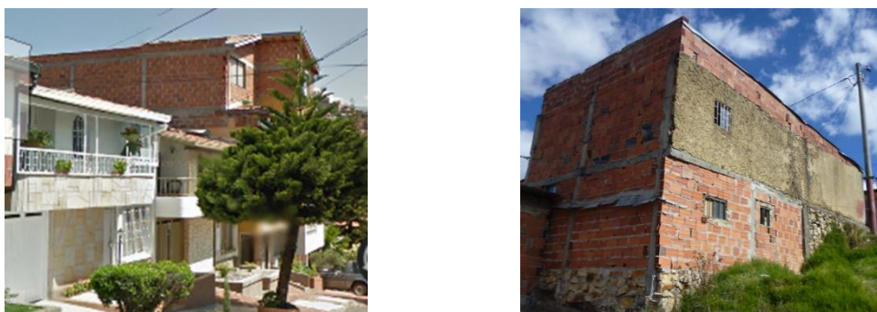
Figura 7. Edificaciones de mampostería confinada dúctil (izquierda) y mampostería confinada no dúctil (derecha) presentes en la ciudad de Medellín, © Google 2016.
