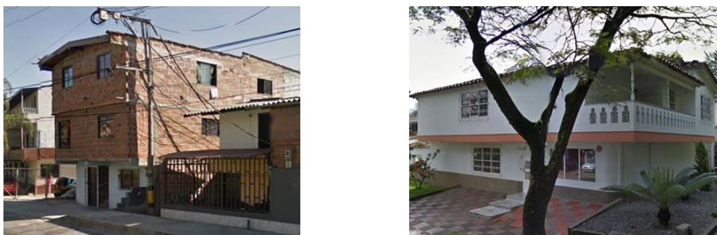
Figura 6. Edificaciones de mampostería simple por procesos de autoconstrucción (izquierda) y construidas antes del código (derecha) de la ciudad de Medellín, © Google 2016.
