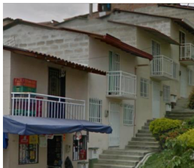
Figura 5. Casas de mampostería reforzada en Medellín, © Google 2016.
