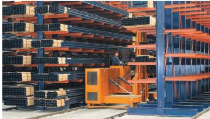
Figura 9. Sistema de estanterías cantiléver.
