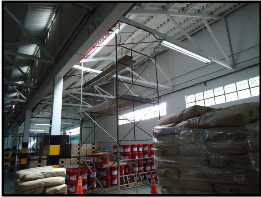
Ilustración 38 Mejora al interior del Almacén General 1
