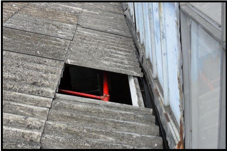
Ilustración 40 Arreglos donde se filtraba el agua 1
