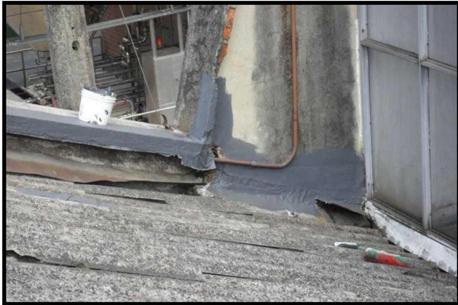
Ilustración 41 Arreglos en filtraciones de agua 2
