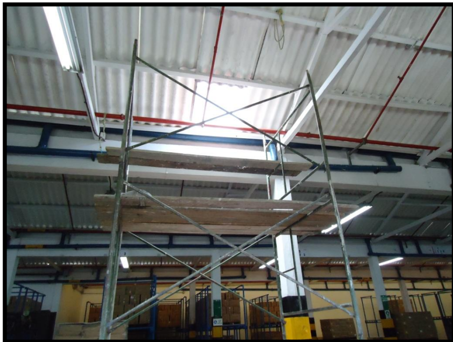
Ilustración 39 Mejora al interior del Almacén General 2
