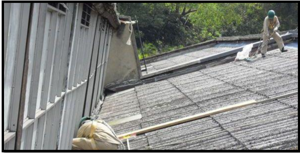
Ilustración 42 Arreglos filtraciones de agua 3
