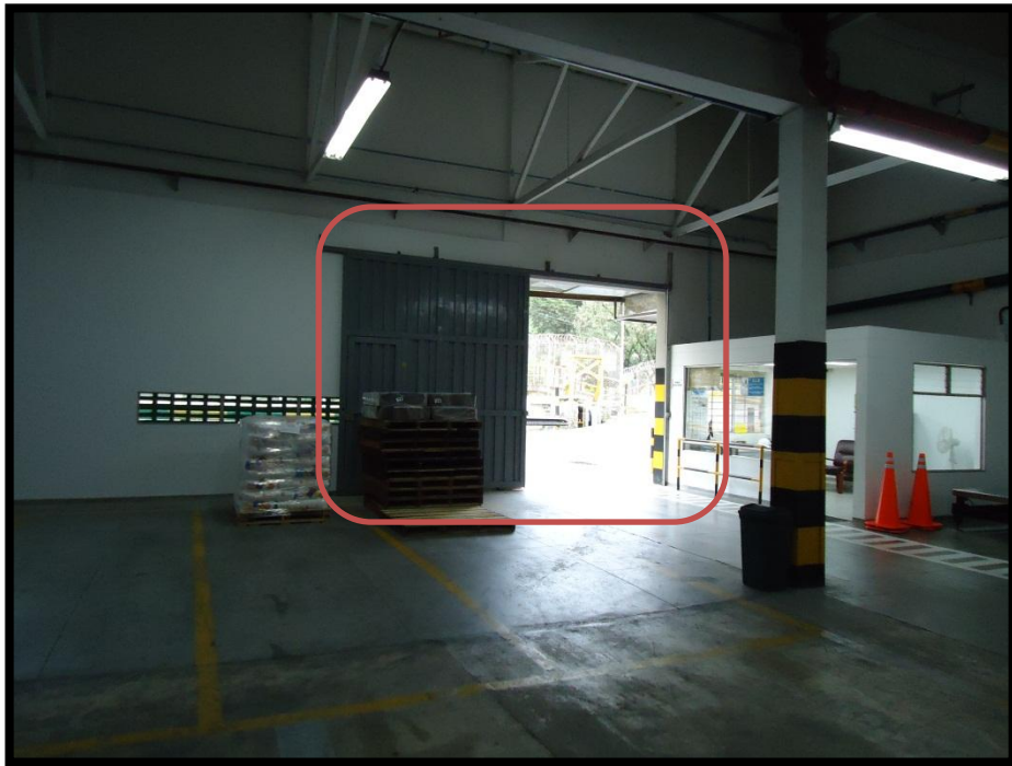
Ilustración 27 Puerta de acceso al almacén
