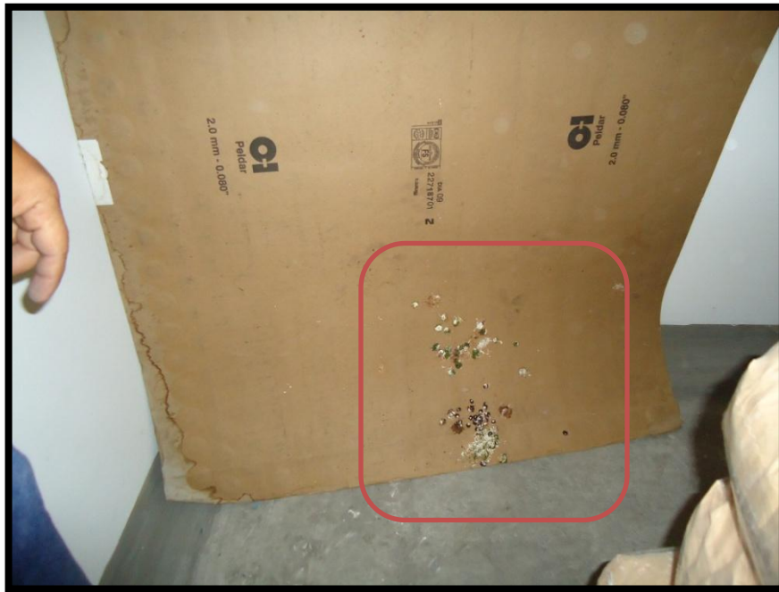
Ilustración 28 Presencia de aves en el interior del almacén
