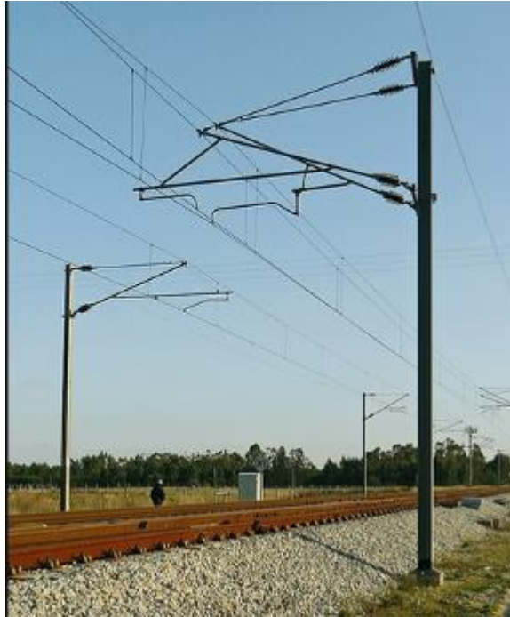
Ilustración 9. Catenaria convencional.
