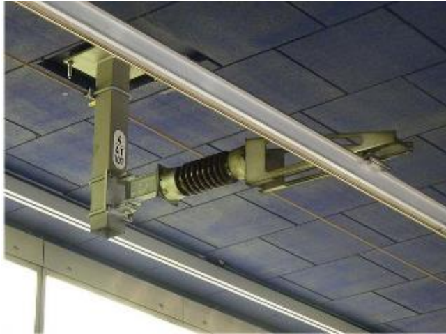
Ilustración 10. Catenaria Rígida.
