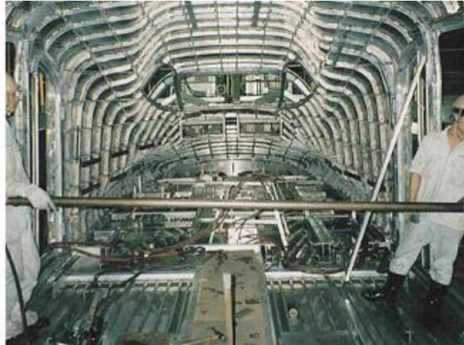
Ilustración 24. Interior de la estructura
