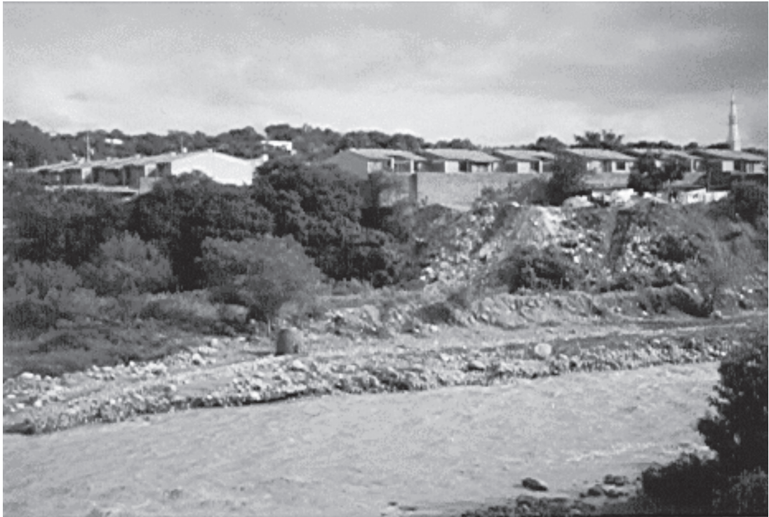
Figura 1. Invasión de la ronda de río Pamplonita Conjunto Residencial (las aguas residuales son vertidas directamente a la corriente hídrica)
