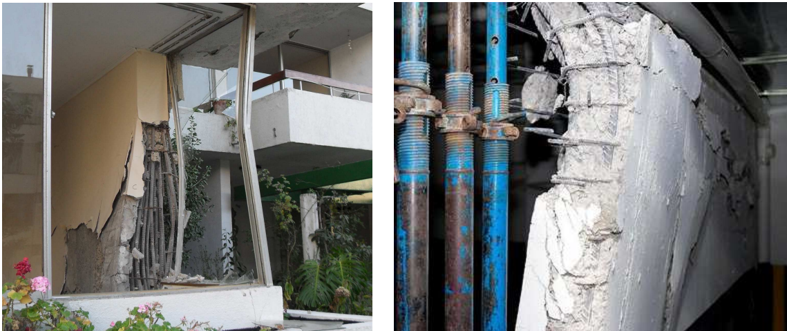
Figura 16. Rotación inelástica deficiente Chile (2010). Fuente: Rochel (2010).
