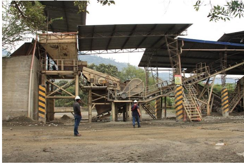
Figura VIII. Equipo de trituración de material
