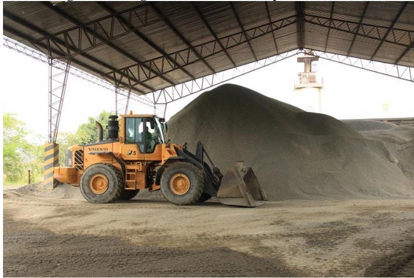
Figura XI. Cargador de alimentación, planta de asfalto
