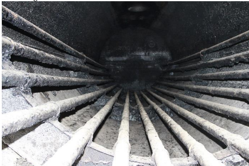
Figura XII. Detalle del sistema de calentamiento del asfalto
