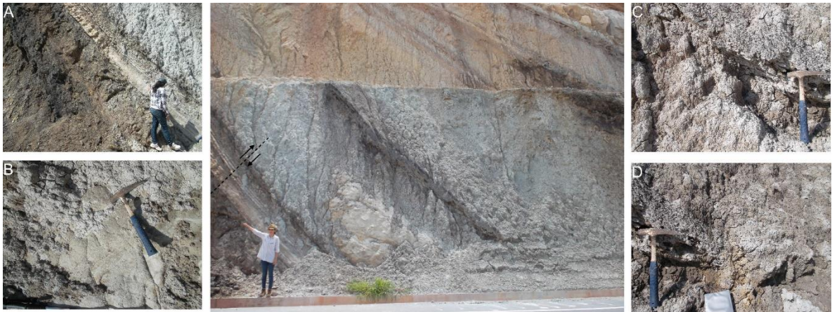
Figura 24 a. Litoarenita feldespática afectado por falla inversa, b. Subarcosa fino, c. Lodolita gris friable, d. Carbón de 0,35m
