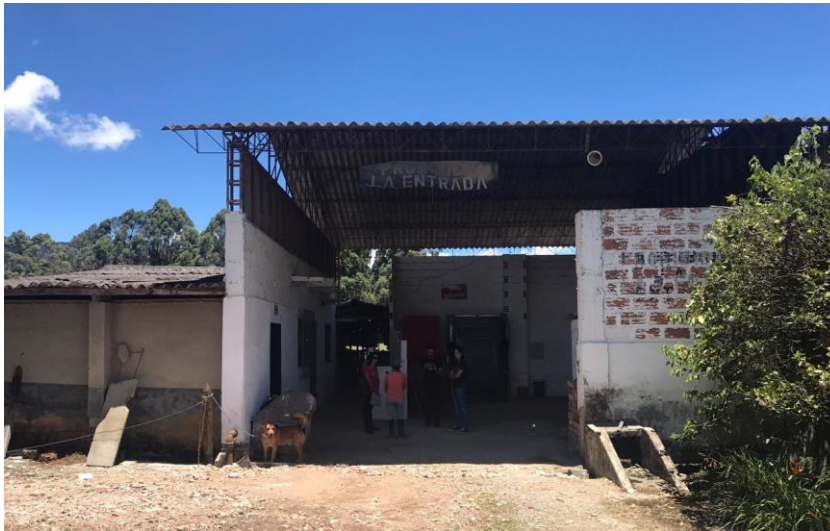
Figura 15. Zona de carga
